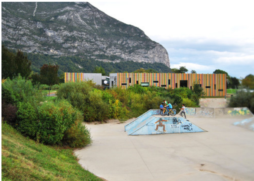
Vue depuis le skatepark Crédit photo : copyright architecte
